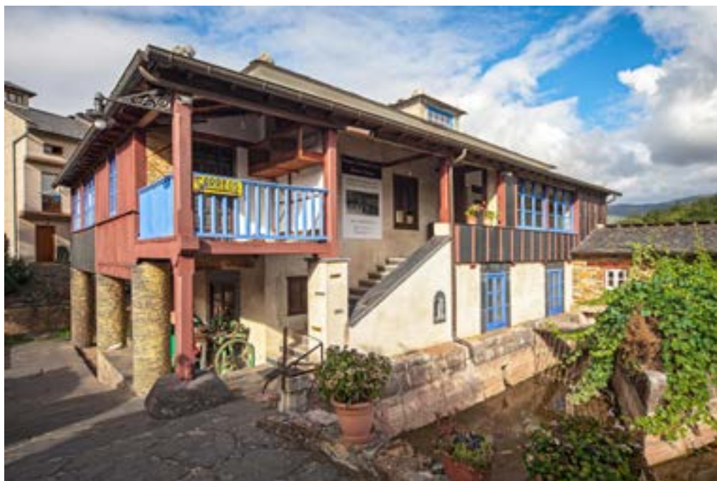
Casa del Molieiro e banzaio del molín hidráulico. Foto: Cámara.
