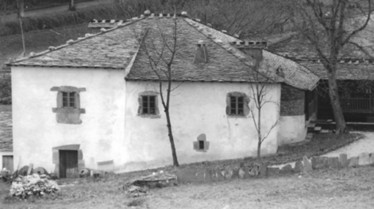
La Casa Rectoral al concluir las obras de rehabilitación, en 1989. Foto: Salvador Rodríguez.
